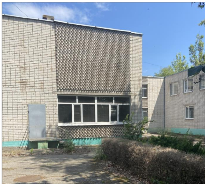
Нежитлова будівля вул. Синенка Сергія, 67а
